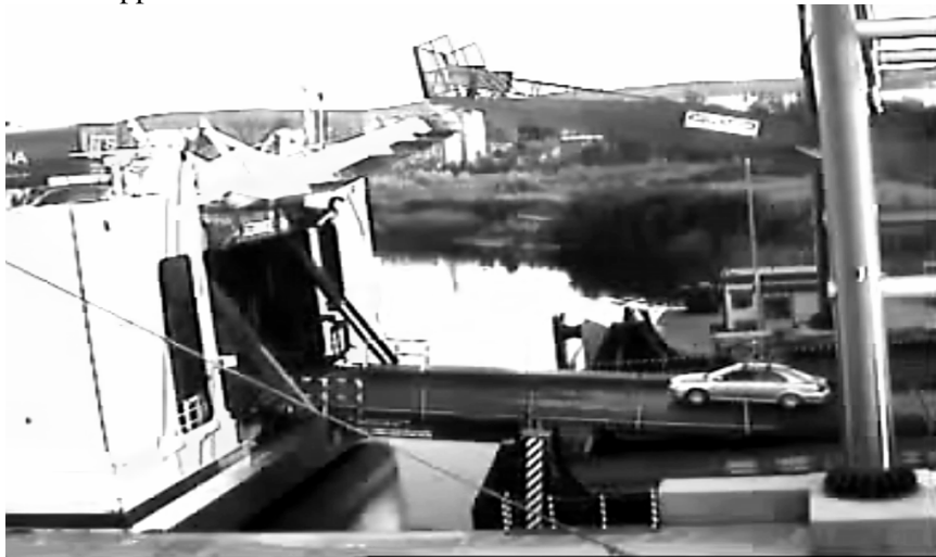
Fig. 1. Dangerous close proximity of the ferry ramp with the approach bank Rys. 1. Niebezpieczne zbliżenie rampy promu do pomostu
